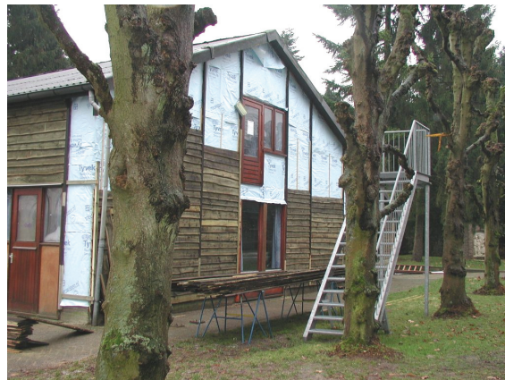
De buitenkant van de kampschuur van Assel Don Bosco Centrum wordt geheel vernieuwd.
